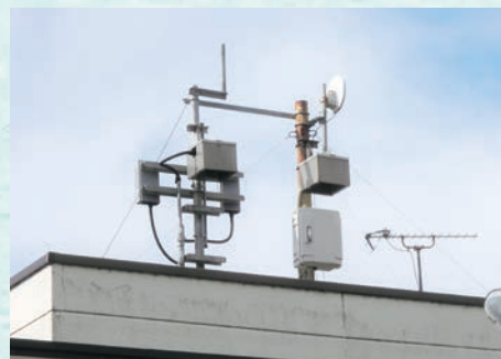
守衛所の臭気センサー及びガス検知器
