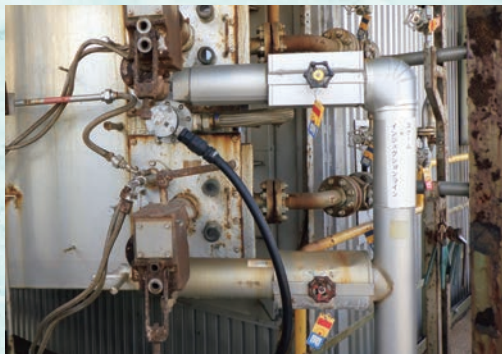
ボイラーsteamインジェクション (steam吹込により排ガス中の窒素酸化物を低減します)
