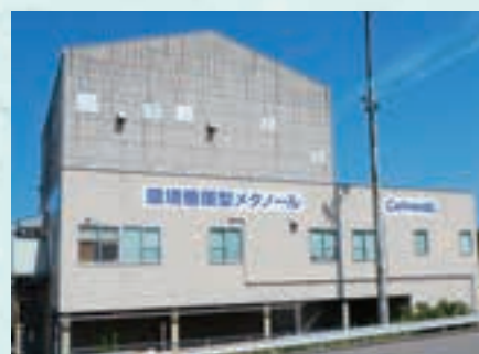
バイオメタノール製造装置建屋
