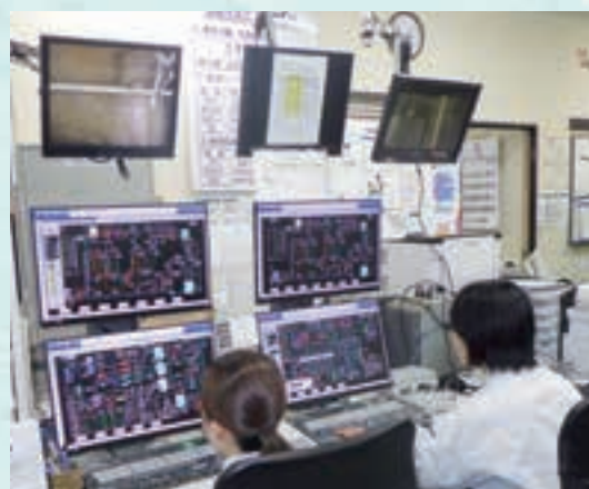
活性汚泥装置管制室 (排水処理状況を 24 時間集中監視しています)
