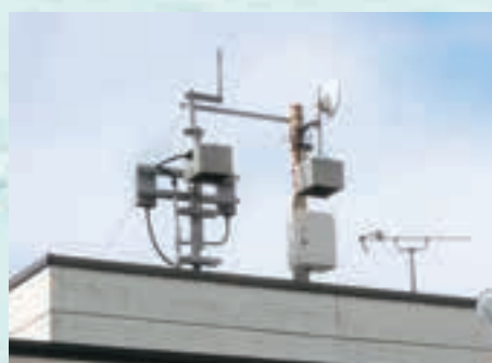
守衛所の臭気センサー及びガス検知器
