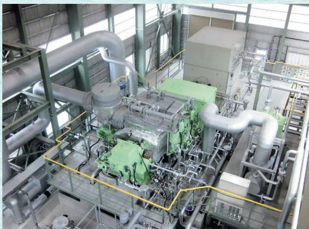
当工場では1957年以降アンモニアを生産してきましたが、国内需要の減少および装置の老朽化を背景に2015年7月末に生産を停止いたしました。これに伴い、アンモニア生産のために使用していた高圧スチームの有効利用を図るため、2016年末に新たにスチームタービン発電機を導入致しました。また、自家発電装置を更新し、工場内の電力・スチームなどの需要に柔軟に対応できる体制を整えました。
