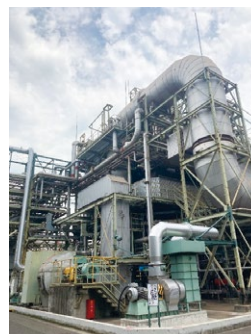
単独化工事で GHG 削減に成功した高圧ボイラー
