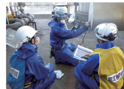
専門の検査会社による板厚測定
