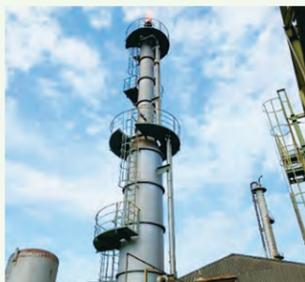
オフガス制御を最適化して天然ガス使用量を削減したフレアスタック
