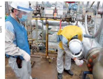
認定検査管理組織による気密試験
