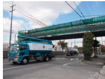
県道横断配管ガスケット交換作業
