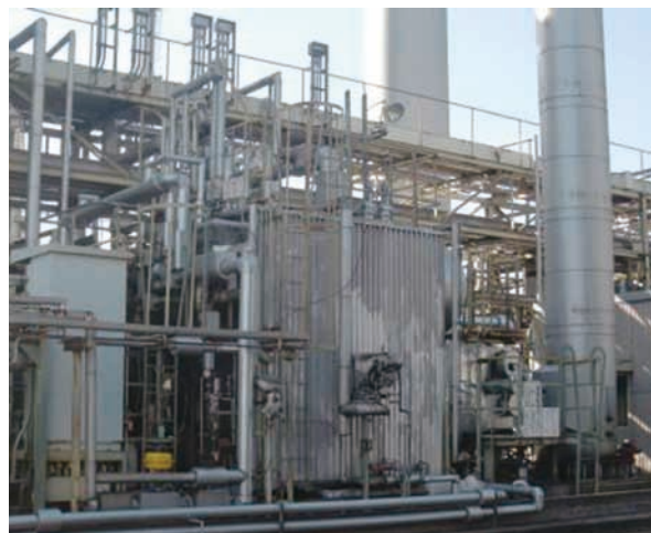
（写真1）熱回収による蒸気発生量を増加させたG-3ボイラー
