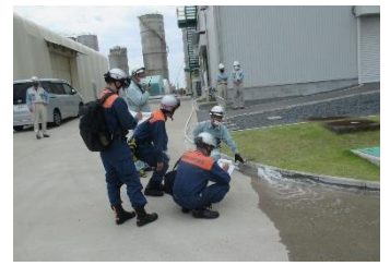
新規設備消防検査
