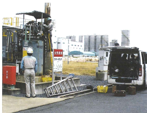
ボイラーばい煙測定
