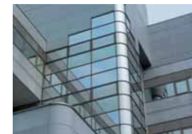
遮熱フィルムを貼り付けた窓ガラス (平塚研究所)
