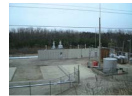
新潟工場天然ガス採掘基地事故現場
