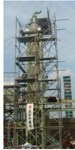
公害防止関連投資 硫化水素の緊急時除害設備 (建設中)
