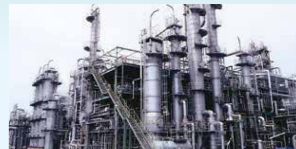
新潟工場のプラント
