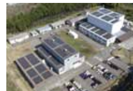
太陽光パネルを全屋根に設置
