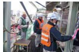
定修パトロール (水島工場)
