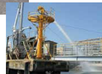
海上放水訓練(水島工場)
