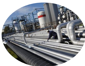
配管等のコーティング
