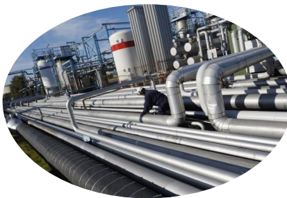
パイプコーティング
