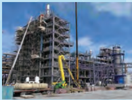
オランダ(MXDA/建設中)
