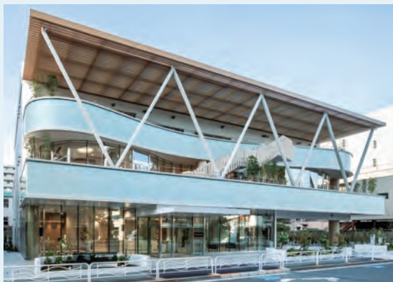
イノベーションセンター「MGC Commons」(東京都江東区木場)
