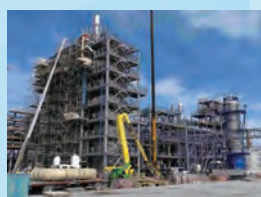
オランダ(MXDA/建設中)
