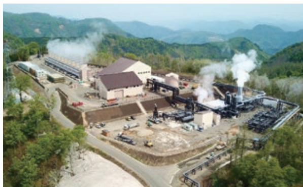
山葵沢地熱発電所(全景)
