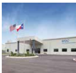
北米 超純過酸化水素 新工場建設
