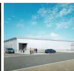
工場野菜の生産・販売事業を行う合併会社を設立・生産工場の建設
