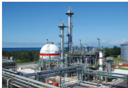
▲新潟工場内のジメチルエーテルプラント
