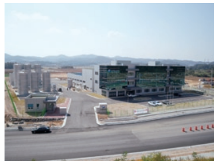
建設が進む天安市の新工場
