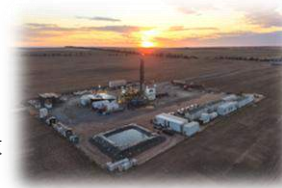
豪州における掘削工事風景
