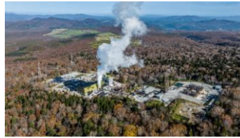
安比地熱発電所 提供:安比地熱(株)
