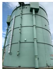
消化ガスホルダ (ガス吸着精製)
