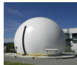
消化ガスホルダ (受け入れタンク)
