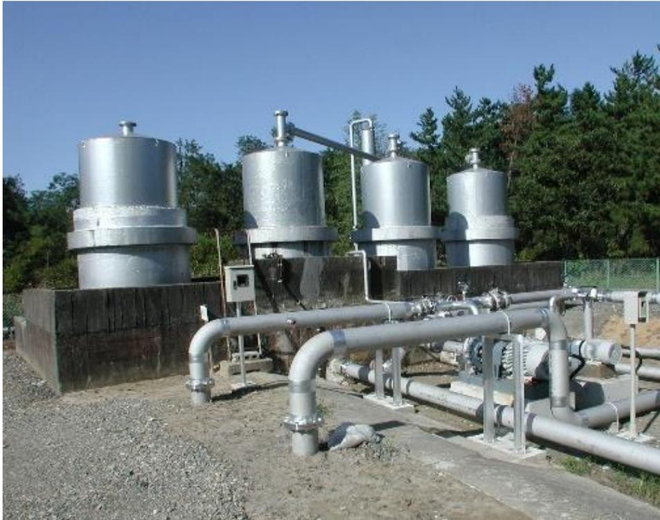
水溶性かん水から天然ガスとヨウ素を分離した後、天然ガスから水素を分離し、発生した二酸化炭素をかん水と共に地下に圧入することによってガスの2次回収を試みる
