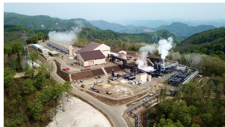
山葵沢地熱発電所
