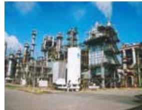
采用三菱瓦斯化学开发的新型ACH法（无硫酸铵副产品的绿色工序），生产用于塑料及涂料等的MMA。（照片：三菱瓦斯化学新潟工厂MMA设备）
