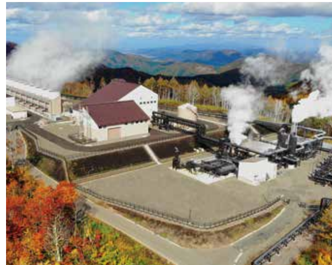
地熱発電は季節、気候の変化の影響を受けないため、電力の安定供給に貢献します。CO 2 排出量が小さく、地球温暖化の防止施策として有効なクリーンエネルギーです。(写真:秋田県山葵沢地熱発電所)
