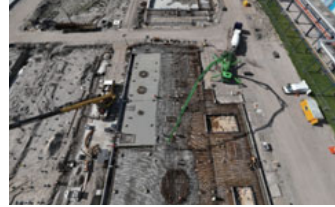
2024 オランダ(MXDA/建設予定地)
