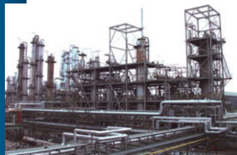
1968 超強酸HF-BF 3 によるキシレン分離技術
