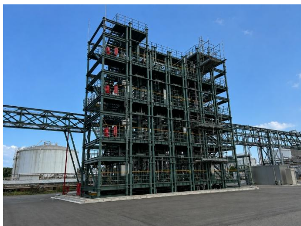
本実証設備の外観
