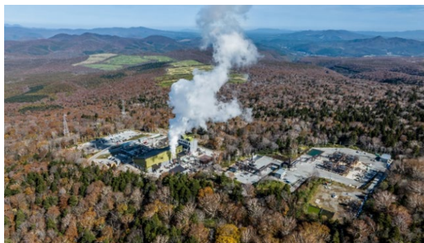
安比地熱発電所 提供:安比地熱(株)
