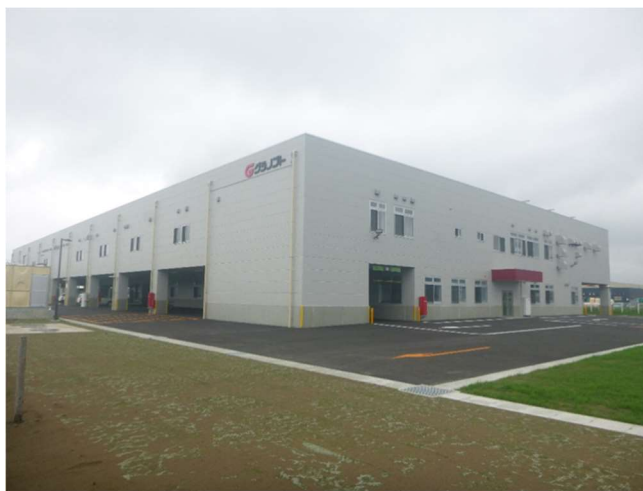
グラノプト新工場 外観
