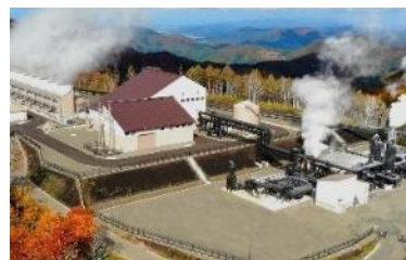
山葵沢地熱発電所 提供:湯沢地熱(株)
