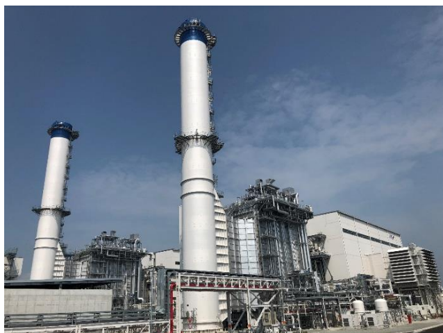
発電所地上から(右手前が2号機、左奥が1号機)
