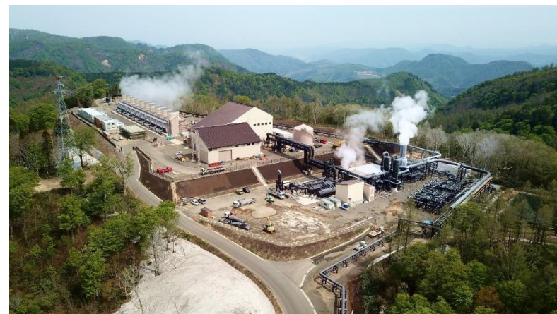
山葵沢地熱発電所
