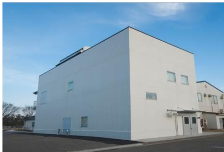
サンプル製造専用設備外観
